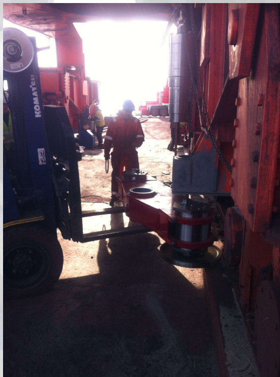
Demontering av boogie
